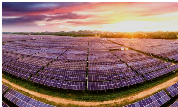
地面光伏电站
